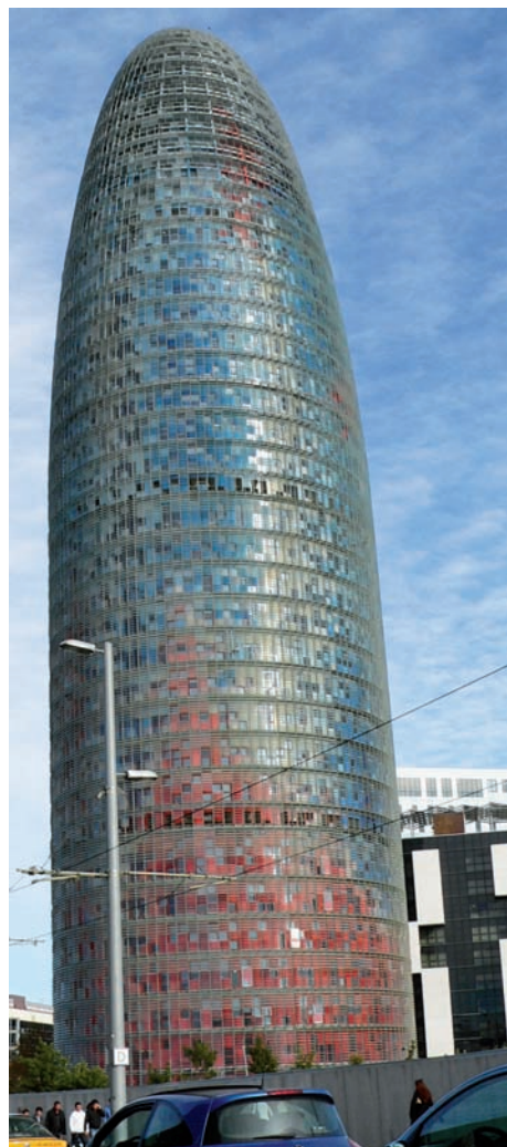
Torre Agbar à Barcelonne, signée Jean Nouvel, une Tour de 38 étages
